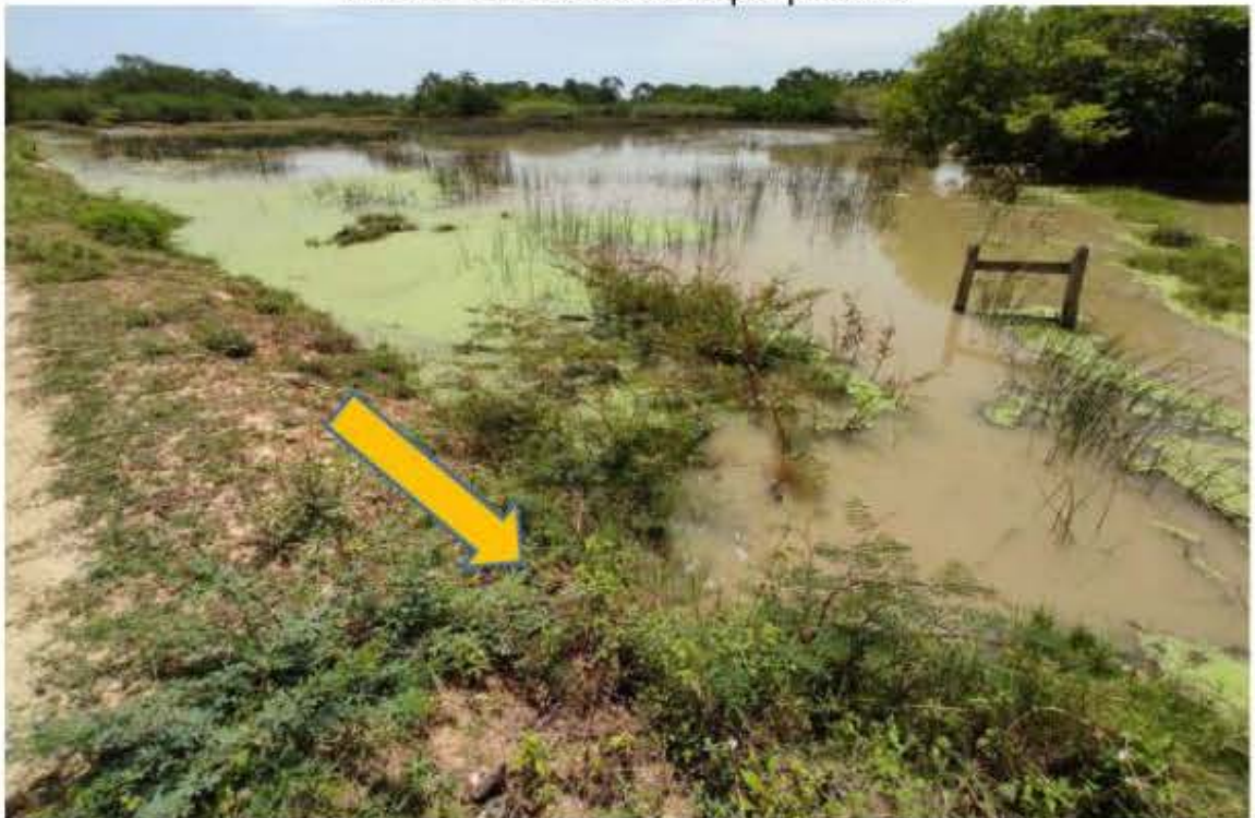
Foto 8. Tubería #1 en dique privado.
