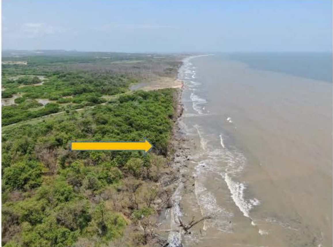
Foto 1. Erosión de la franja costera Ciénaga de Los Manatíes-Arroyo León.
