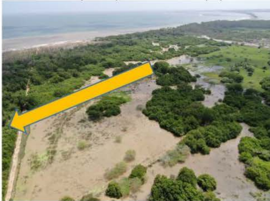
Foto 7. Área represada por construcción de dique privado.
