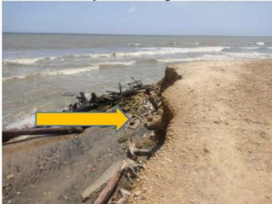
Foto 2. Alta erosión en la franja costera Ciénaga de Los Manatíes-Arroyo León.
